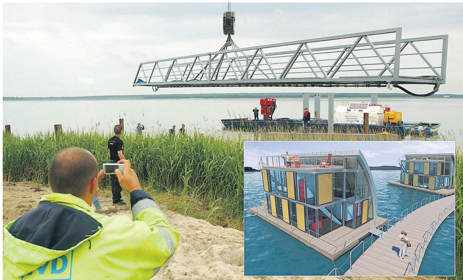
Das Stahlgerüst der 24 Meter langen künftigen Landgangbrücke des Wohnhafens Scado ist am Freitag am Kranhaken eingeschwebt und auf Pontons verankert worden. Die Computeranimation rechts im Bild zeigt im Modell, wie die „ar-che“-Häuser am Steg verankert auf dem Wasser des Sees liegen sollen.
