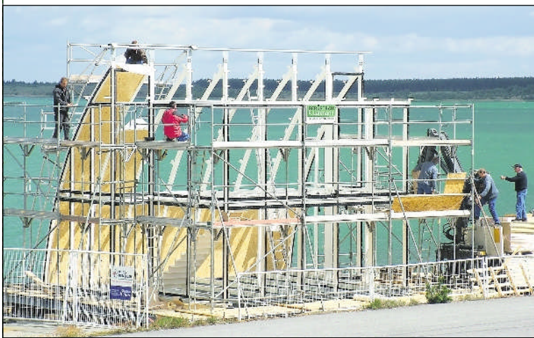
Derzeit wird am Geierswalder See nördlich von Hoyerswerda das erste schwimmende Haus für den geplanten Wohnhafen Scado montiert. Im Juli soll das Haus fertig beplankt, verlastet und mobilisiert sein. Dann dient es als Musterhaus für den Wohnhafen. Das allererste schwimmende Haus im Lausitzer Seeland befindet sich bereits seit einigen Jahren auf dem benachbarten Partwitzer See. Foto: Anja Waller
